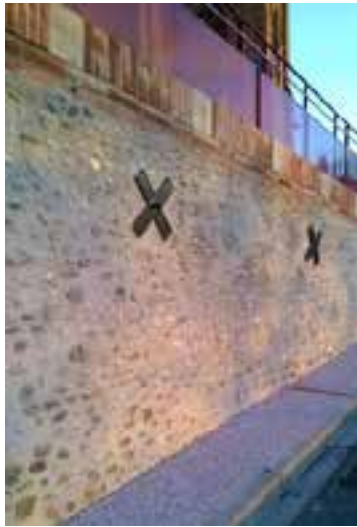
Côté Route de Lagardelle
