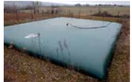
Réserve d'eau (bâche de 120 m 3 )
