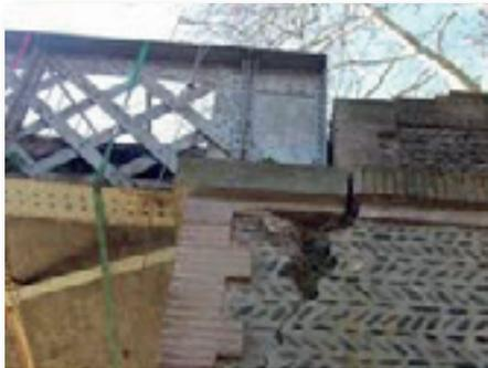
Peu de temps après, un accident de la circulation **causé par un camion-toupie a fait bouger la structure.**
